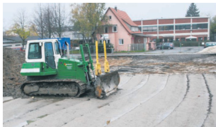
Es wird gebaggert: Vor der hinten liegenden Kulturwerkstatt lässt die Stadt an der Bahnhofstraße einen Parkplatz bauen. FOTO: KOSBAB
